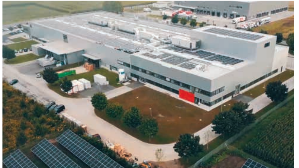
Der Zubau vergrößert das Werk auf 11.300 m 2 , 18.000 m 2 misst die Photovoltaikanlage.
